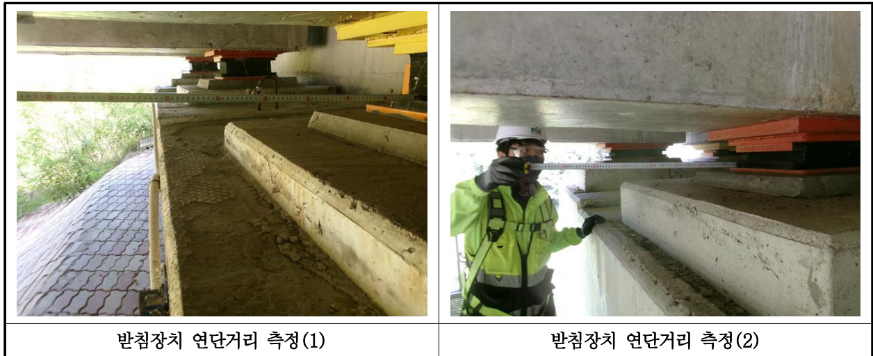
【사진 27.3.15】 교량받침장치 연단거리측정
