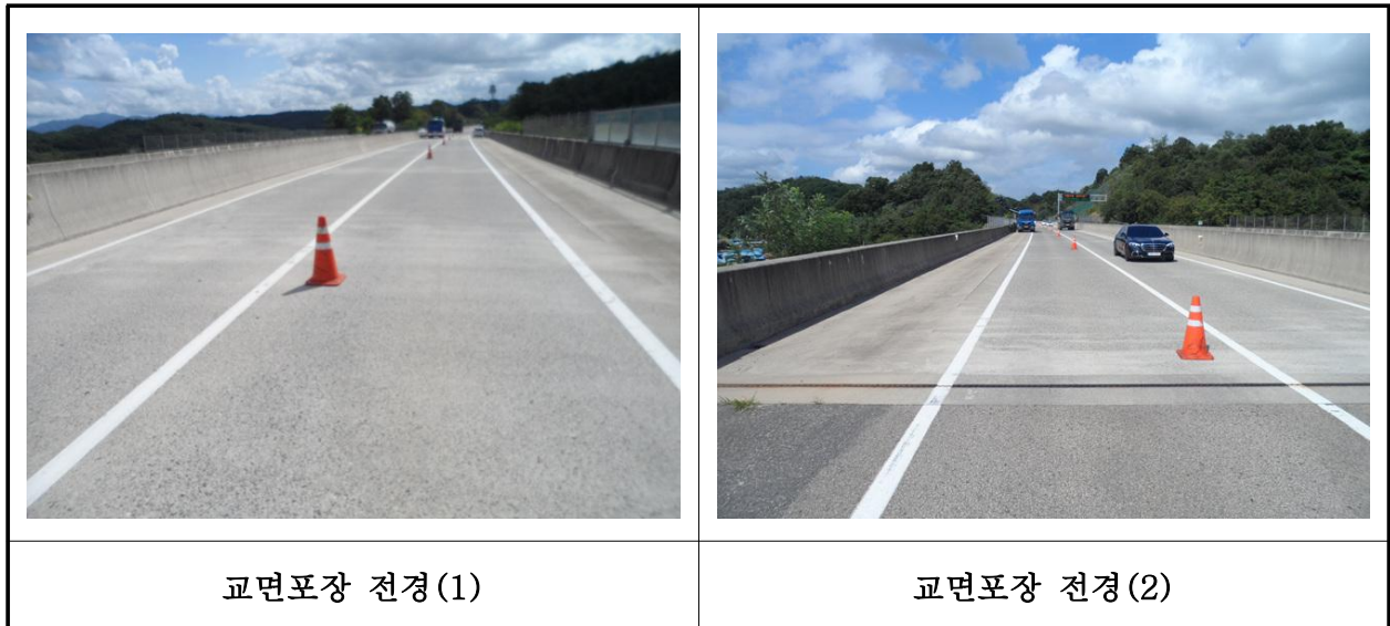
【사진 27.3.47】 교면포장 전경
