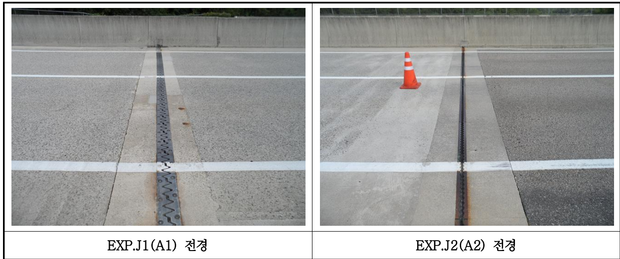
【사진 27.3.44】 신축이음장치 전경
