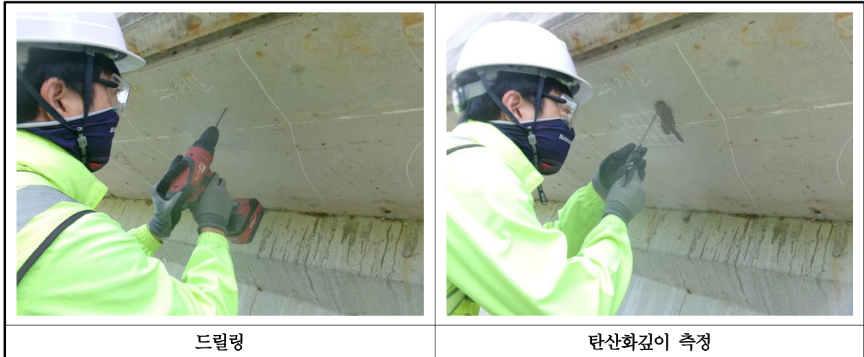
【사진 27.4.3】 탄산화 깊이 측정 현장사진
