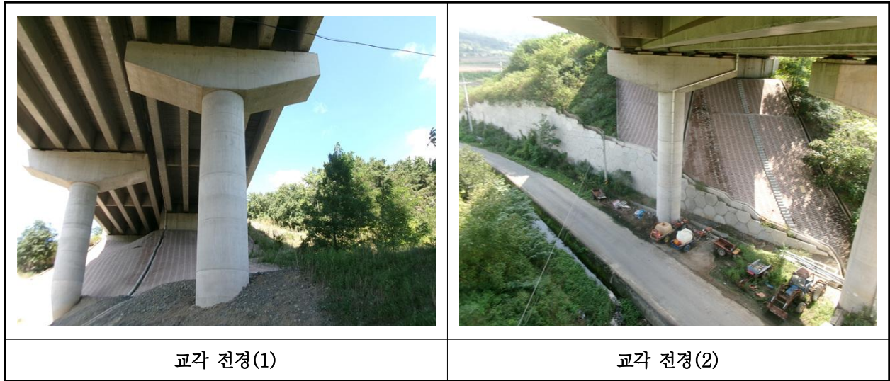
【사진 27.3.10】 교각 전경
