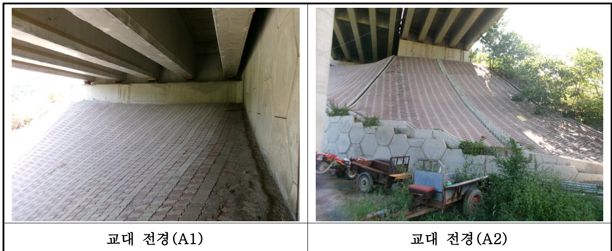
【사진 27.3.35】 교대 전경
