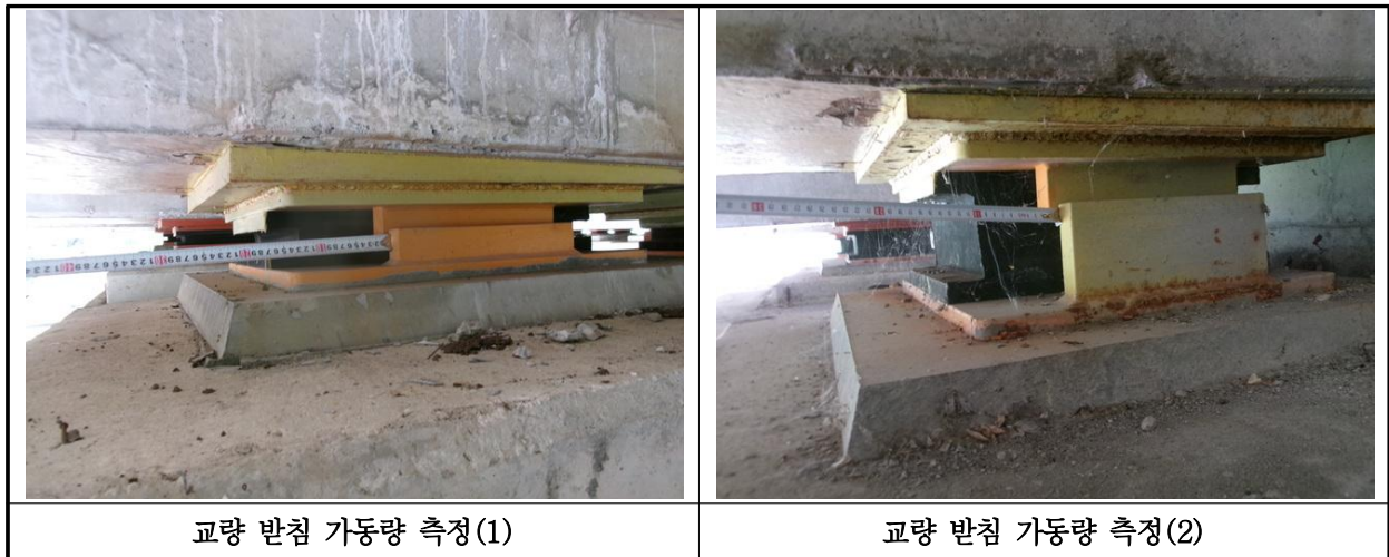
【사진 27.3.43】 교량받침 이동량 측정
