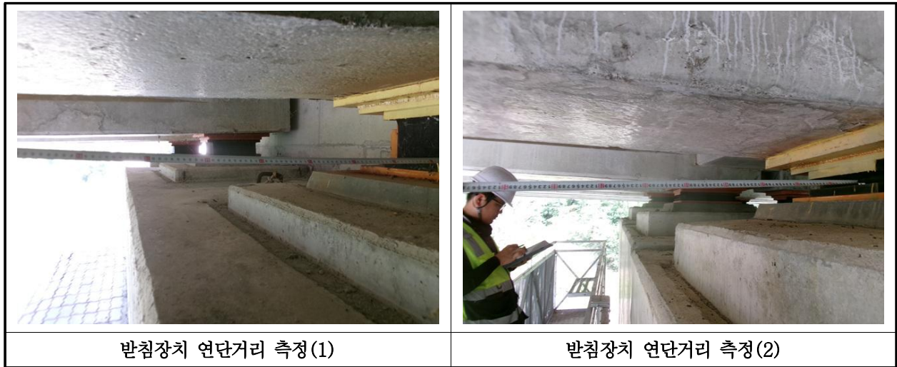
【사진 27.3.42】 교량받침장치 연단거리측정
