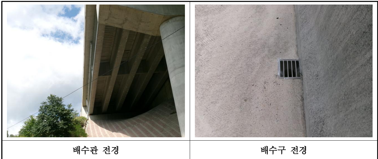
【사진 27.3.49】 배수시설 전경
