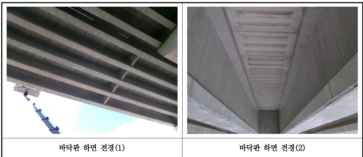
【사진 27.3.29】 바닥판하면 전경
