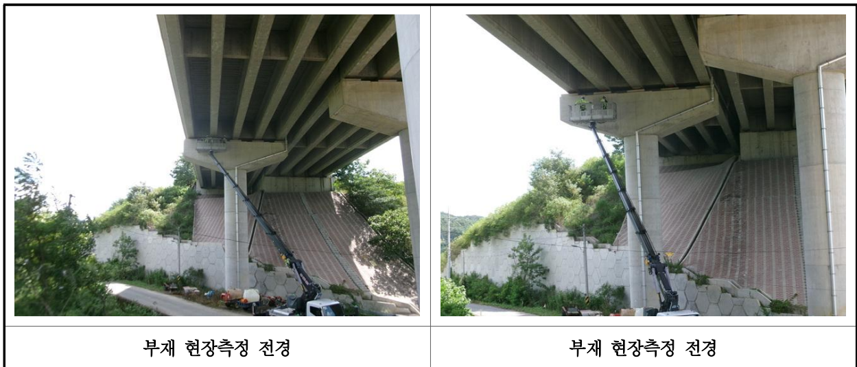
【사진 27.2.1】 부재 현장측정 전경
