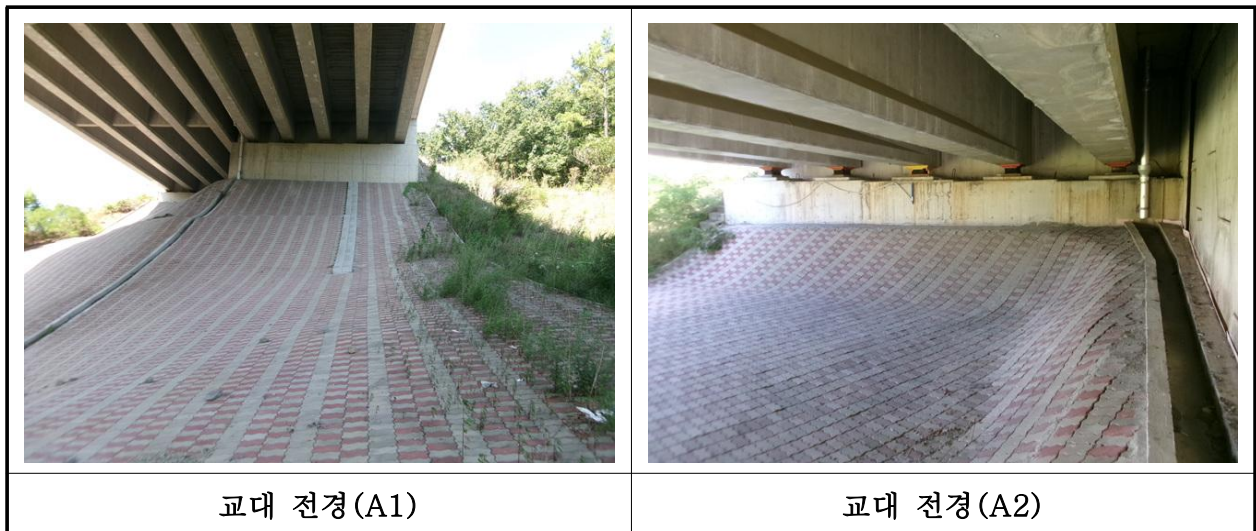
【사진 27.3.8】 교대 전경
