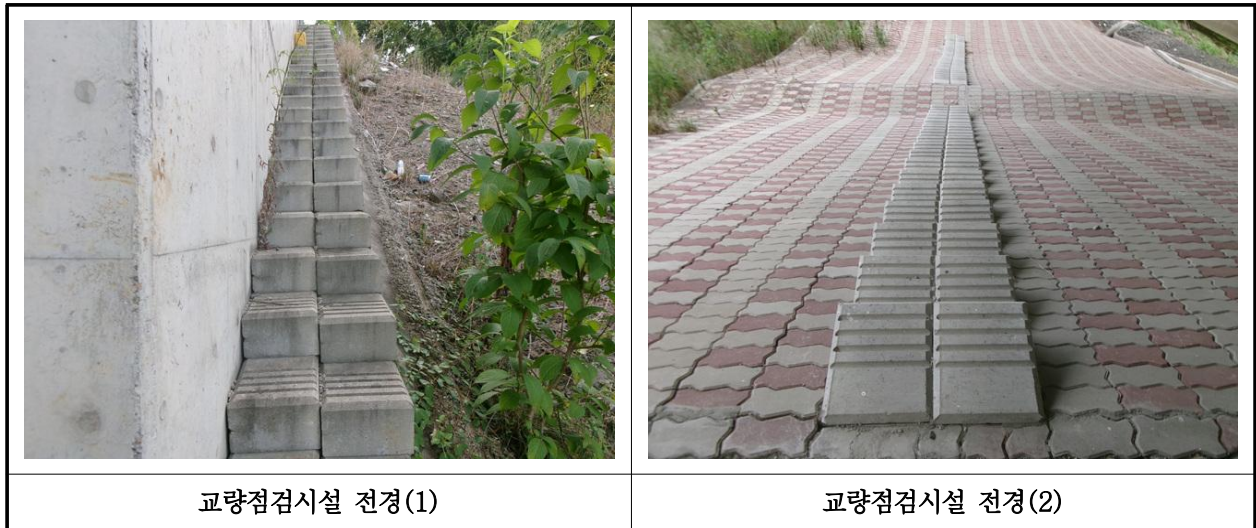
【사진 27.3.26】 교량 점검시설 전경
