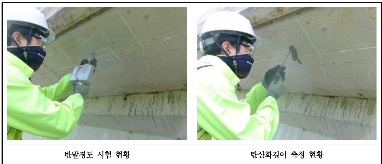
【사진 27.4.1】 콘크리트 내구성조사 현황
