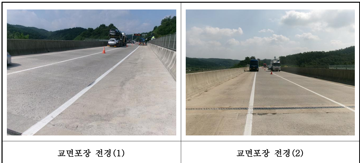
【사진 27.3.20】 교면포장 전경
